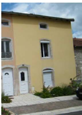
Encadrement en pierre des ouvertures avec linteaux délardés
