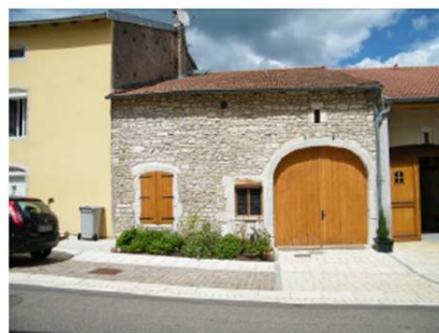
Porte charretière en anse de panier, encadrement en pierre des ouvertures Volets persiennes
