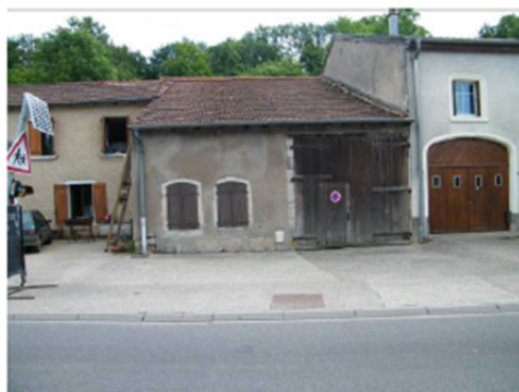
Porte charretière avec linteau bois, encadrement en pierre des ouvertures avec linteaux délardés Volets persiennes
