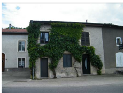
Encadrement en pierre des ouvertures Fenêtre et porte d'entrée avec linteaux délardés Volets persiennes
