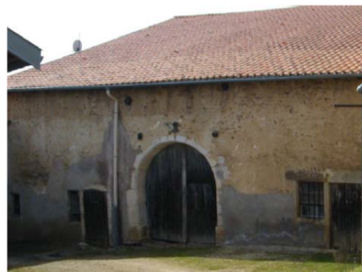
Porte charretière, encadrement en pierre
