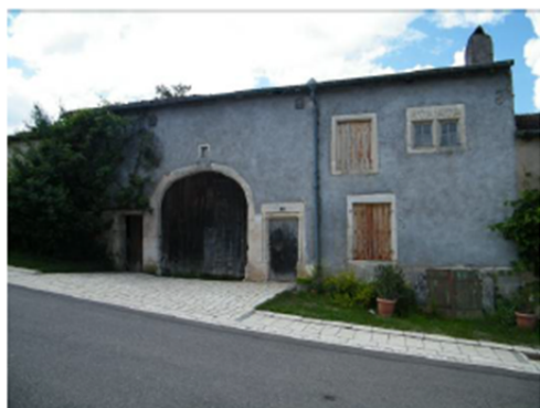
Encadrements en pierre de la porte charretière plein cintre, encadrement en pierre des ouvertures, encadrement mouluré autour des 2 fenêtres en haut à droite, volets persiennes
