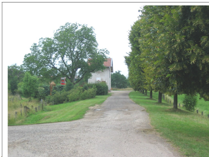
Ancienne gare le long de l'ancienne voie ferrée bordée de Tilleuls et d'un noyer ..
