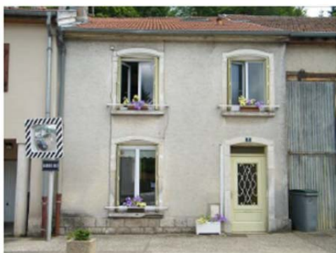
Encadrements en pierre des ouvertures avec linteaux délardés
