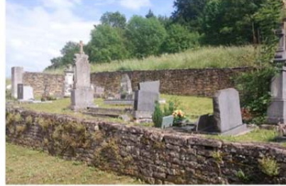
55- Mur en pierres sèches, autour du cimetière
