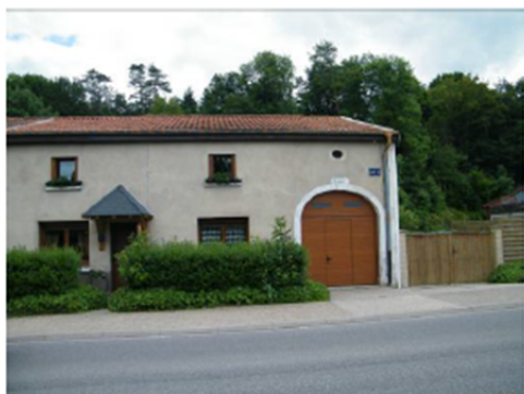
Porte charretière en anse de panier + clef de voute Œil de bœuf
