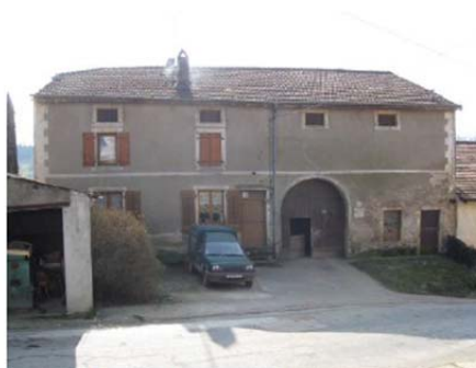
Porte charretière, encadrement en pierre
