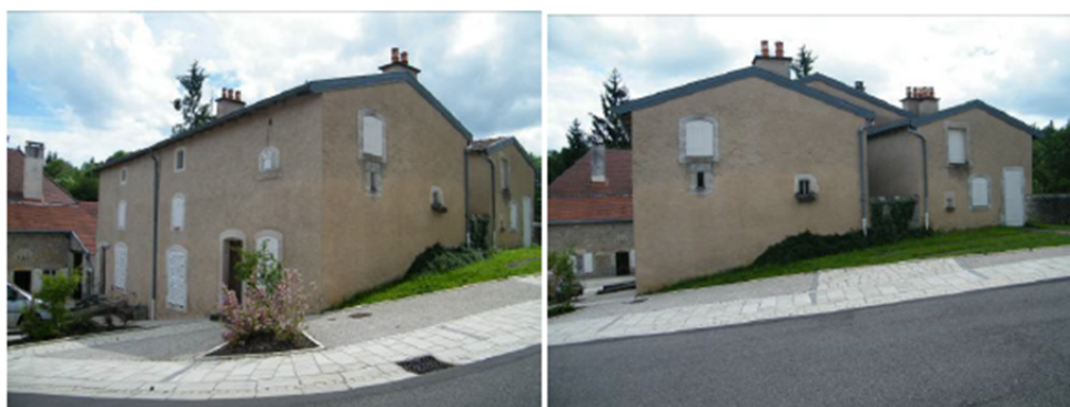
Encadrements en pierre des ouvertures avec linteau délardé Volets persiennes 3 niches
