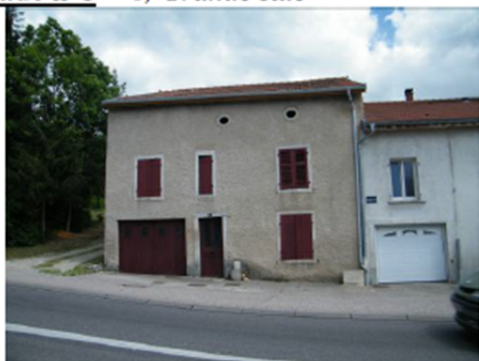
Encadrements en pierre des ouvertures, Œils de bœuf (x2) Volets persiennes
