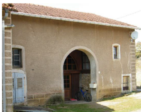
Porte charretière, encadrement en pierre
