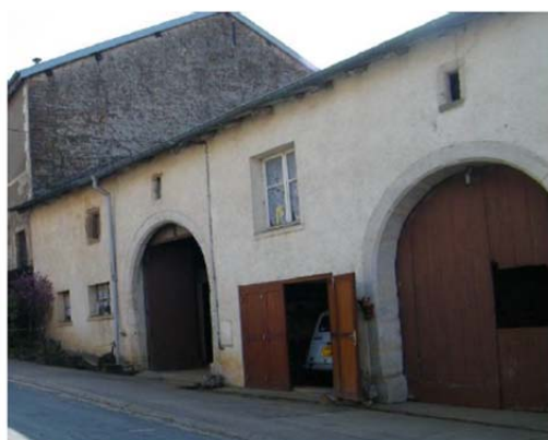
Porte charretière, encadrement en pierre
