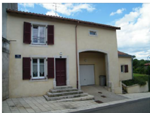
Encadrements en pierre de la porte charretière Encadrement en pierre des ouvertures Volets persiennes
