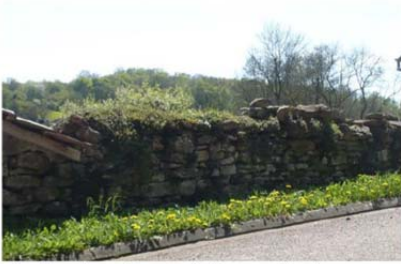
42- Muret en pierres sèches rue Haute
