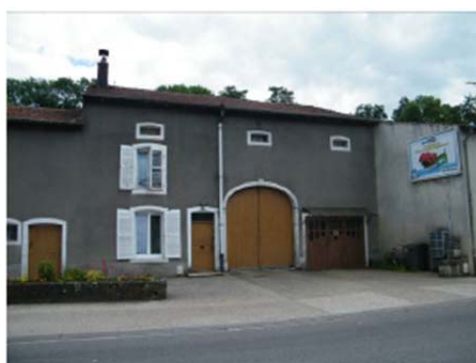
Porte charretière en anse de panier + clef de voute, Encadrement en pierre des ouvertures avec linteaux délardés, Volets persiennes
