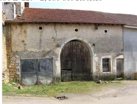
Porte charretière, encadrement en pierre
