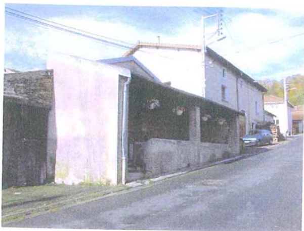
Lavoir rue Clémenceau.
