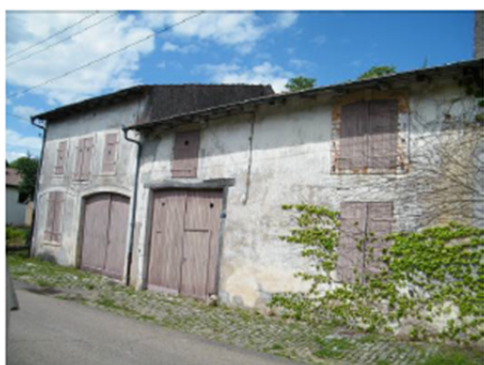
Porte charretière avec linteau en bois Double encadrements arrondis en pierre, encadrement en pierre des fenêtres, Volets persiennes
