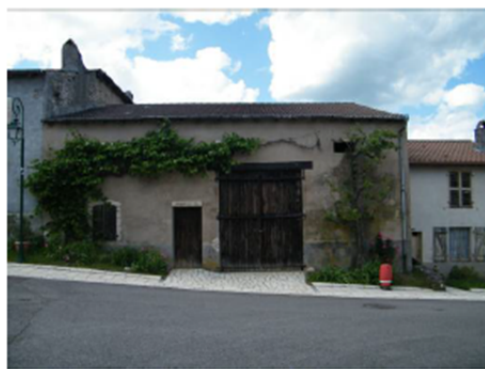
Encadrement en pierre des ouvertures, linteau délardé
