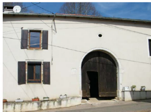
Porte charretière, encadrement en pierre
