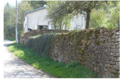
44- Muret en pierres route de Vicherey
