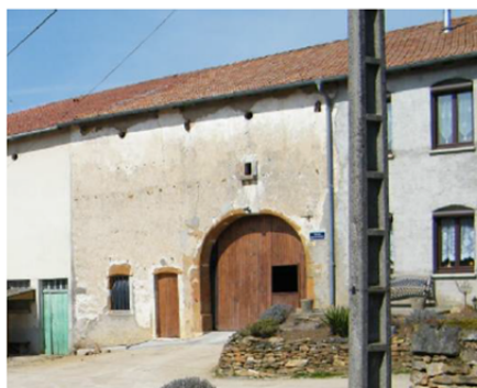
Porte charretière, encadrement en pierre
