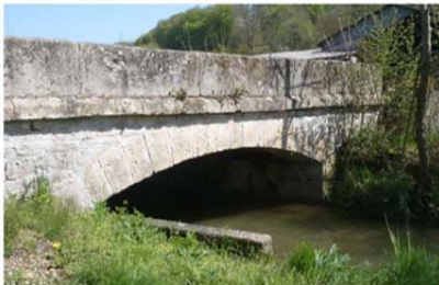
30- Pont du Haut
