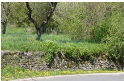
33- Muret en pierres sèches, rue Haute
