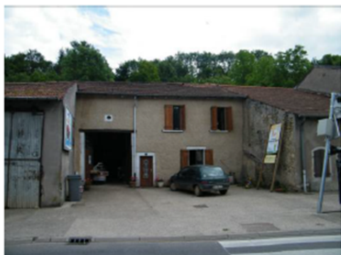
Porte charretière avec linteau en bois Œil de bœuf Volets persiennes
