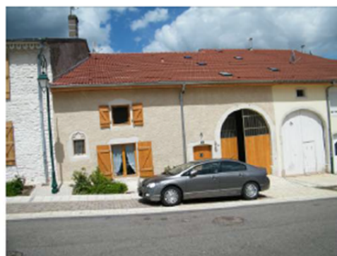
Porte charretière plein cintre, encadrement en pierre des ouvertures, niche abritant une vierge au-dessus de la porte d'entrée, encadrement mouluré autour de la fenêtre de gauche, volets persiennes
