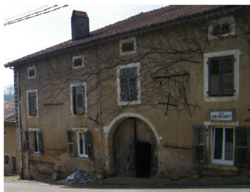
Porte charretière, encadrement en pierre
