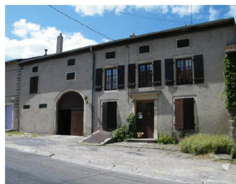
Rythme et dimensions des ouvertures – porte charretière – linteau en pierre sculptée – entrée de cave - pavés
