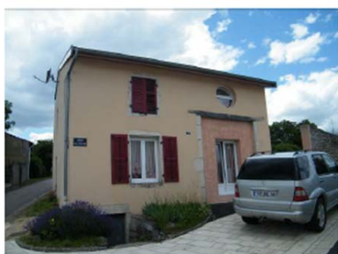
Linteau en bois, encadrements en pierre des ouvertures, volets persiennes
