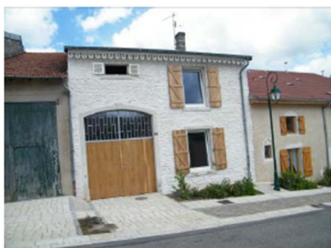
Encadrements en pierre de la porte charretière + clef de voute Encadrement en pierre des ouvertures Volets persiennes
