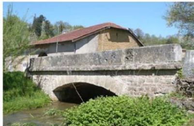
31- Pont du Bas
