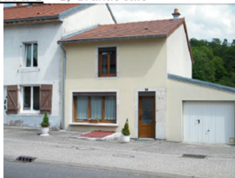
Encadrements en pierre autour des ouvertures
