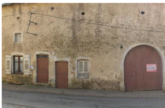
Porte charretière, encadrement en pierre
