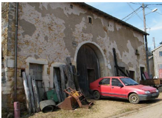
Porte charretière, encadrement en pierre
