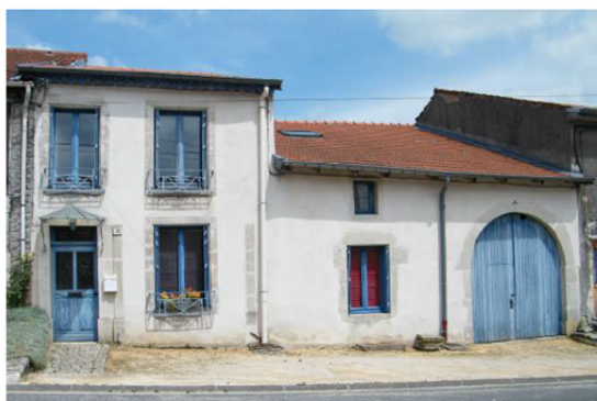
Rythme et dimensions des ouvertures – porte charretière – pavés - marquise
