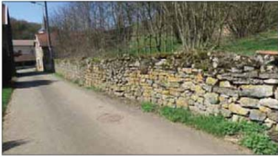
Murs de pierres sèches à l'intérieur du village : adaptation au relief
