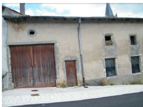
Porte charretière Encadrement en pierre des ouvertures Œil de boeuf
