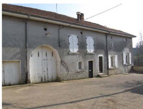
Porte charretière, encadrement en pierre
