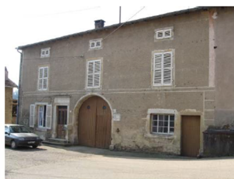
Porte charretière, encadrement en pierre
