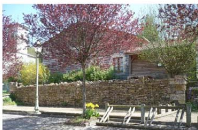
39- Muret en pierres sèches, place des 3 Monts
