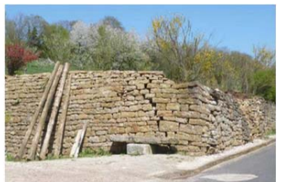
35- Muret en pierres sèches, rue Haute
