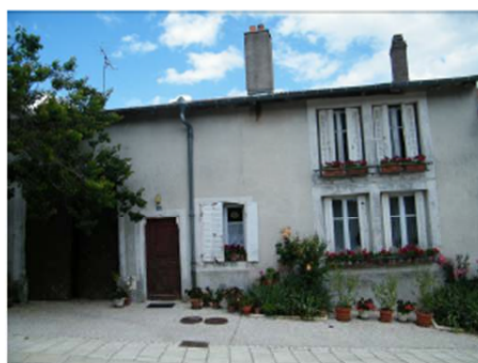
Encadrement mouluré de la porte d'entrée Volets persiennes
