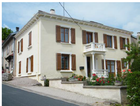
Rythme et dimensions des ouvertures, dessous de toit en pierre
