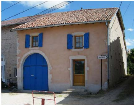
Rythme et dimensions des ouvertures – porte charretière, poterie sur la faîtière
