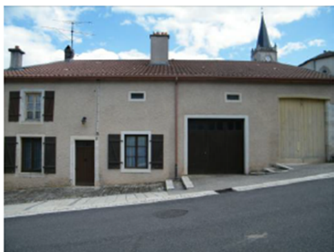
Encadrement en pierre des ouvertures Volets persiennes
