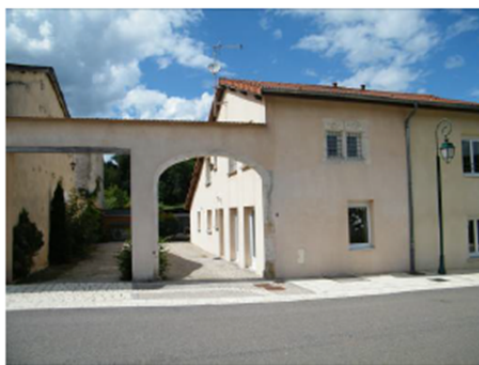
Encadrement en pierre de l'ancienne porte charretière en plein cintre Encadrement mouluré autour des 2 fenêtres en haut à droite de la photo
