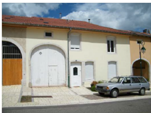
Porte charretière en anse de panier, encadrement en pierre des ouvertures avec linteaux délardés
