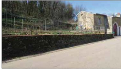
Murs de pierres sèches à l'intérieur du village : adaptation au relief
