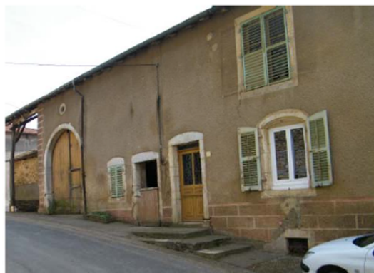
Porte charretière, encadrement en pierre
