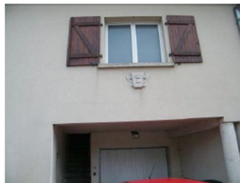
Linteau en bois Encadrements en pierre des ouvertures Clef de voute
