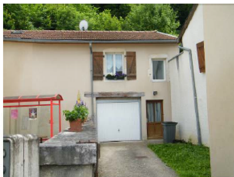
Linteau en bois Encadrements en pierre des ouvertures Clef de voute
