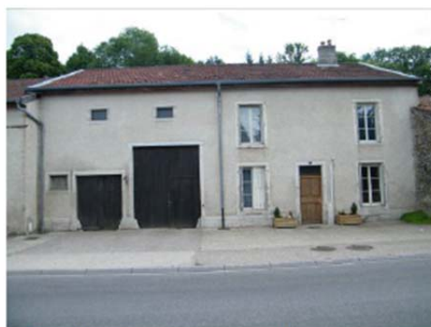
Encadrement en pierre des ouvertures Volets persiennes
