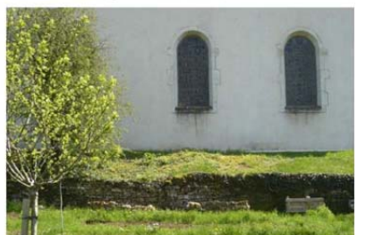
41- Muret en pierres sèches le long de l'église
