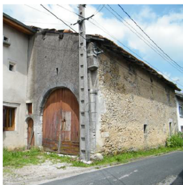
Porte charretière – Niche
