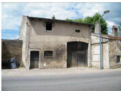
Porte charretière avec clef de voute Encadrement en pierre des ouvertures avec linteaux délardés
