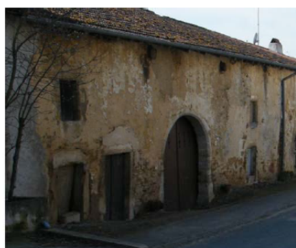
Porte charretière, encadrement en pierre
