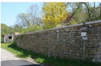
40- Mur en pierres sèches, chemin de Novéant
