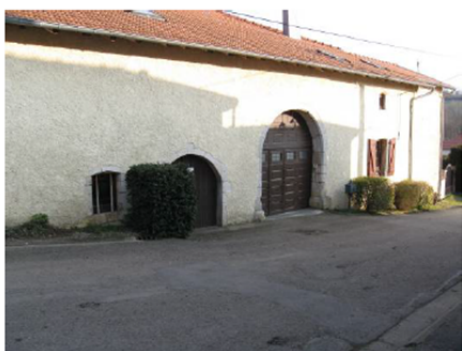
Porte charretière, encadrement en pierre
