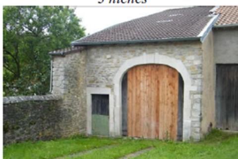
Porte charretière en anse de panier+ clef de voûte, encadrement en pierre des ouvertures
