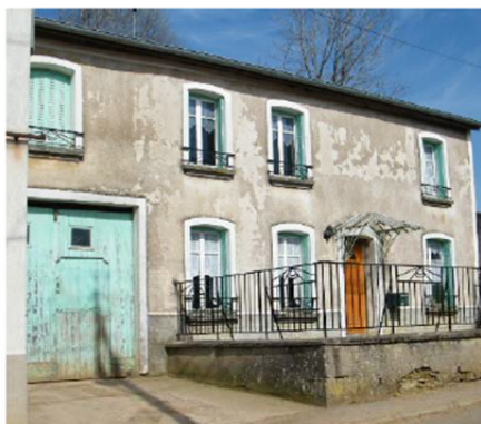
Porte charretière, encadrement en pierre
