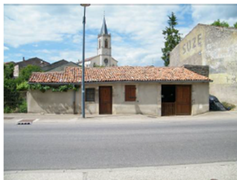
Encadrement en pierre des ouvertures
