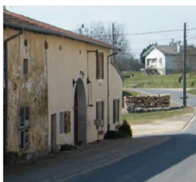
Porte charretière, encadrement en pierre
