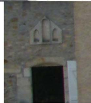
Encadrement en pierre des ouvertures Volets persiennes Triple niche au-dessus de la porte d'entrée
