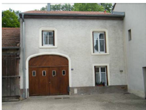
Porte charretière en anse de panier Encadrement en pierre des ouvertures Volets persiennes
