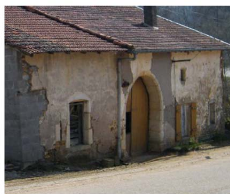
Porte charretière, encadrement en pierre
