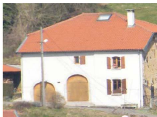
Portes charretières, fenêtres délardées
