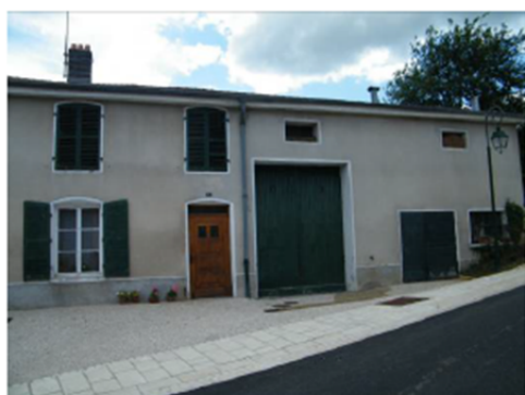
Porte charretière Encadrements avec linteaux délardés Volets persiennes
