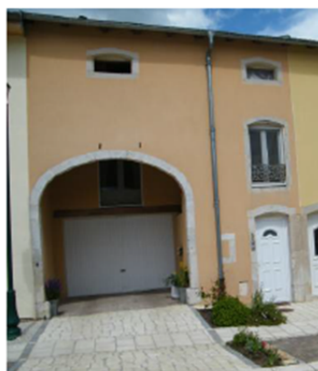
Encadrement en pierre de la porte charretière en anse de panier, encadrement en pierre des ouvertures avec linteaux délardés
