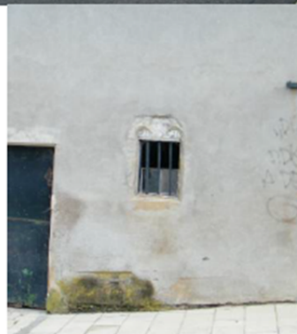
Encadrement en pierre des ouvertures, encadrement mouluré autour de la fenêtre, œil de bœuf
