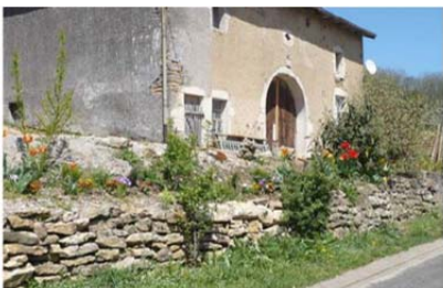
34- Muret en pierres sèches, rue Haute
