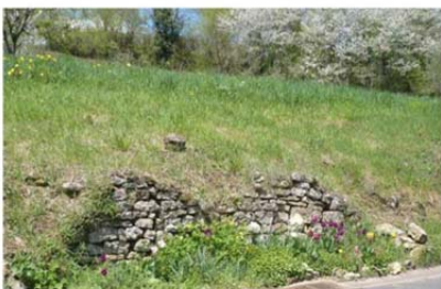
36- Muret en pierres sèches, rue Haute
