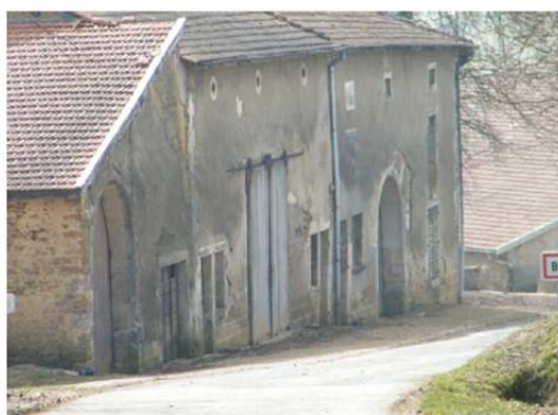
Portes charretières, encadrement en pierre, oeils de boeuf
